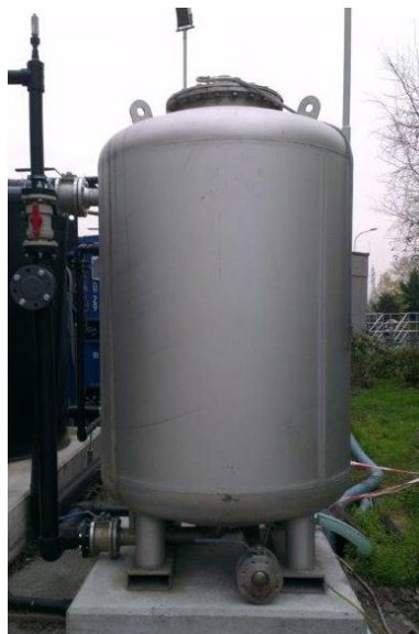
Abbildung 13: Aktivkohle-Druckfilter im Stand-Alone-Betrieb
